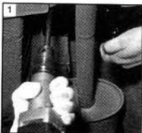
Сквозь отверстия кронштейнов сверлим два отверстия (слева и справа) диаметром 12,5–13 мм.
